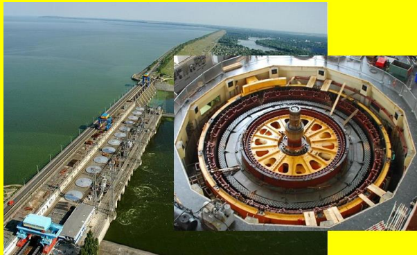
Гідрогенератор Кременчуцької ГЕС
