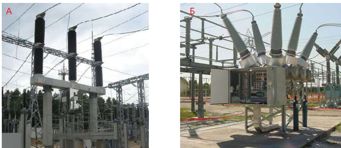
Рис. 1 – Конструкції високовольтних елегазових вимикачів: а – стовпчикового типу; б – бакового типу
