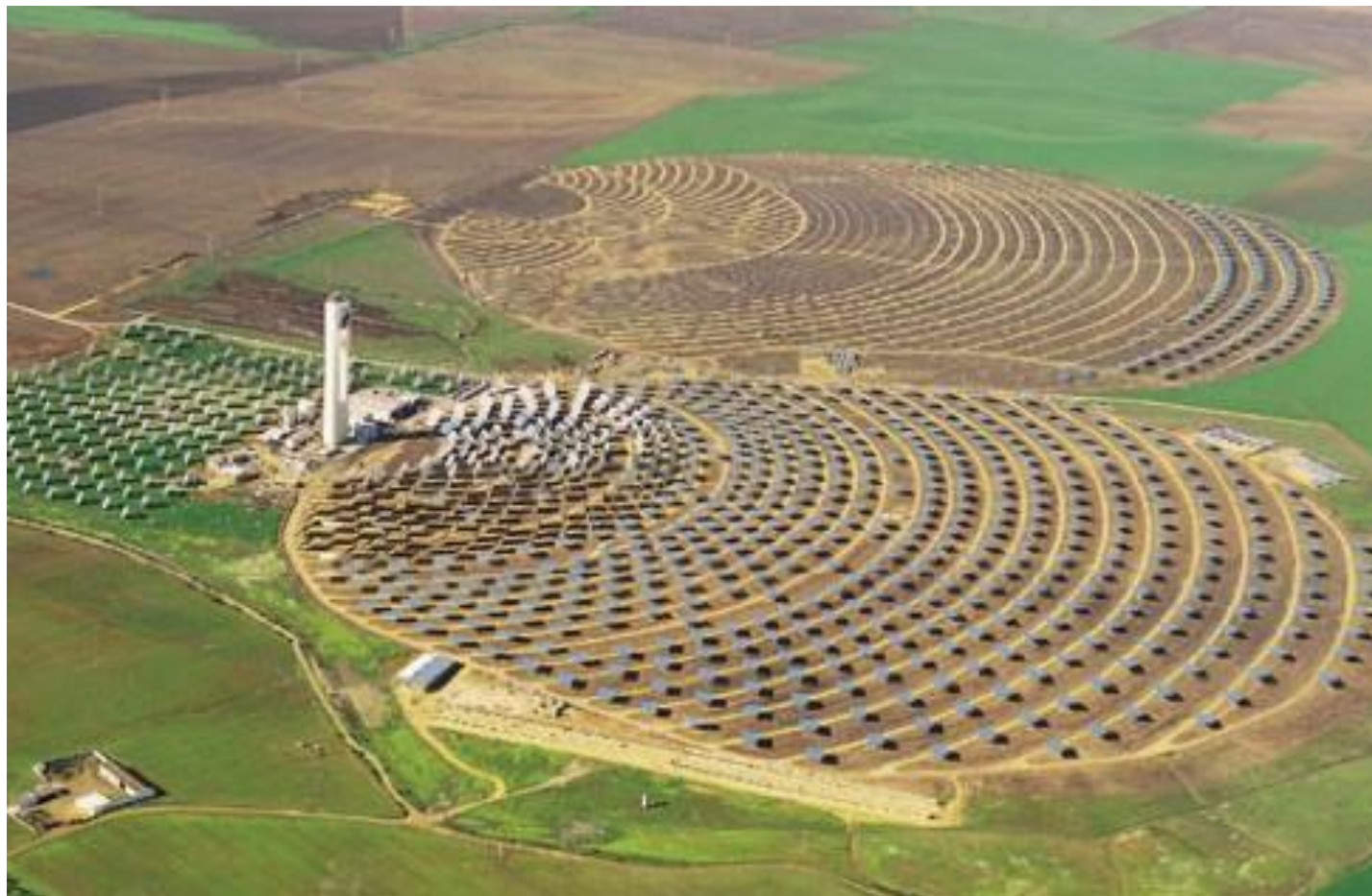
ВИГЛЯД НА СТАНЦІЮ PS1 З ВИСОТИ ПТАШИНОГО ПОЛЬОТУ. НА ЗАДНЬОМУ ПЛАНІ ВИДНА ПЛОЩАДКА, ЯКУ ГОТУЮТЬ ПІД PS2 (ФОТО «SOLUCAR»)
