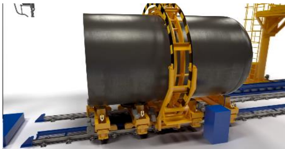
Рис. 19. Переустановлення котла та поєднання його з другою обичайкою центруванням у центраторі
