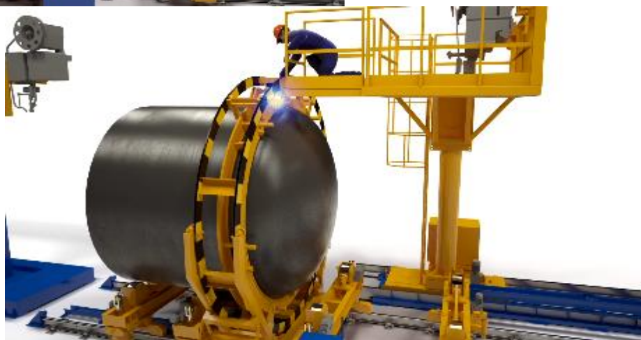
Рис. 16. Виконання зварювальником з велосипедного візка прихваток для поєднання обичайки з першим днищем з фіксованим обертанням котла
