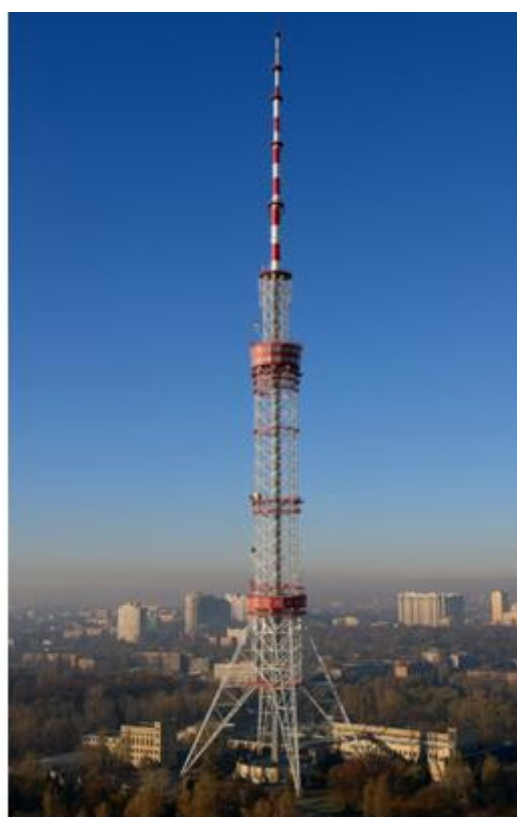
Рис. 5. Саміє больше обекти, що побудовані за допомогою зварювання: a – Ціндаоскій міст у Китаї, довжиною 42,5 км; б – супер танкер «Knock Nevis» вагою 81879 т. та довжиною 485 м.; в – телевізійна вежа у Києві висотою 385 м та вагою у 2700 т
