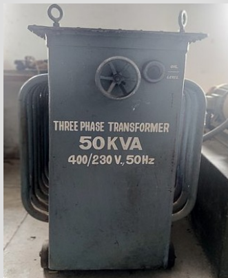
Трифазний трансформатор
