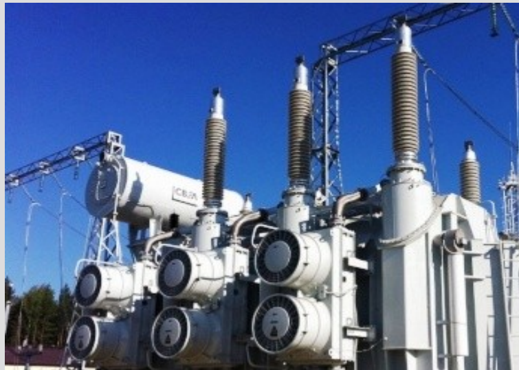
Силовий автотрансформатор
